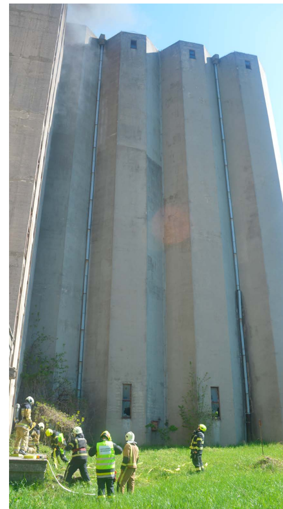
Prve snage brzo pristigle na mjesto požara
