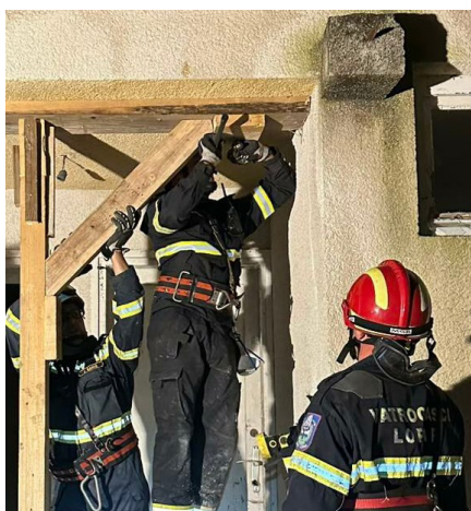
Podupiranje nesigurnih konstrukcija
