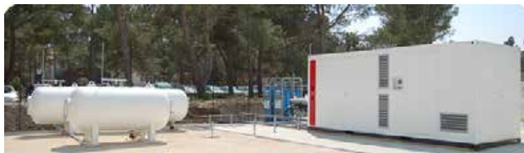
Slika 2. Stabilni sustav za proizvodnju el. energije na vodik
